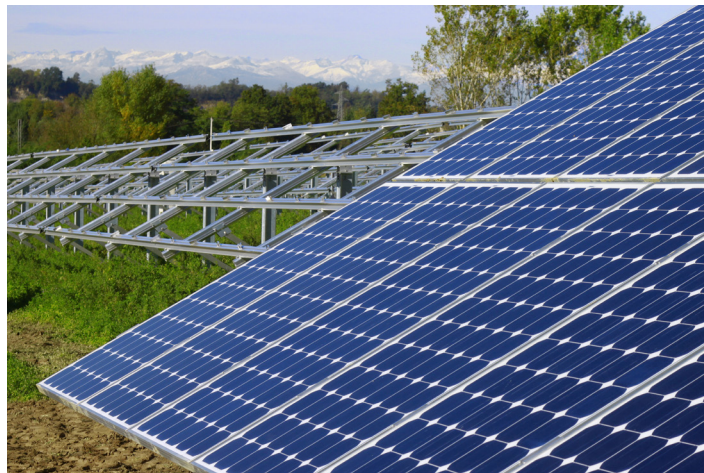
Montajes de acero para las instalaciones fotovoltaicas
