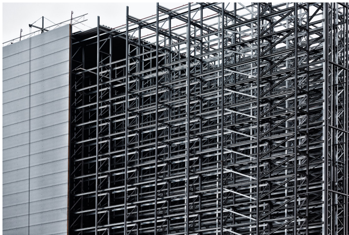
Construcción de racks de gran altura
